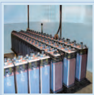
Рис.20 Смонтированная батарея Classic OPzS
